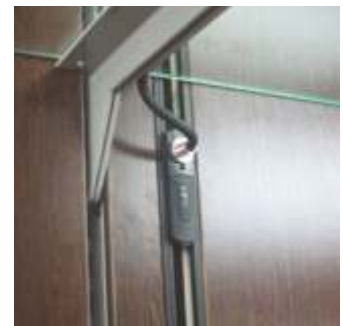
Detalle carril electrificado
